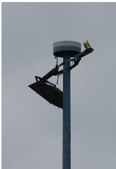
Nevyhovující osvětlení stání M2 a M3, vyžadující rekonstrukci.
