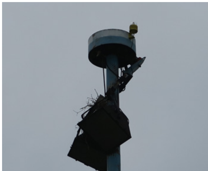
Nevyhovující osvětlení stání M2 a M3, vyžadující rekonstrukci.
