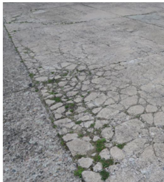
Technický stav povrchu TWY A a APN S, které vykazují vysoký stupeň degradace.
