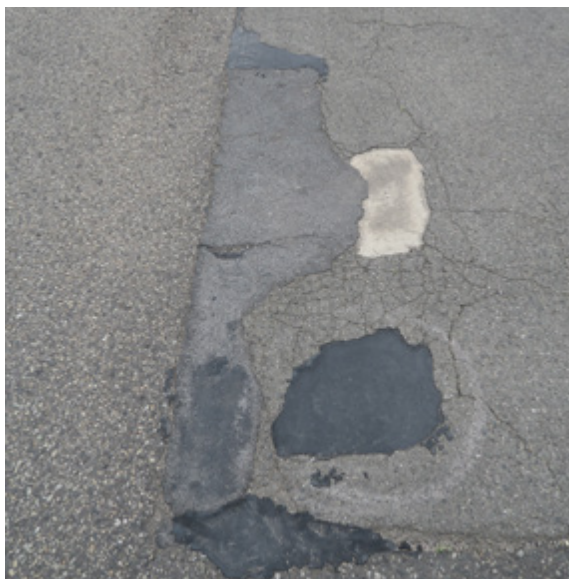
Technický stav povrchu TWY A a APN S, které vykazují vysoký stupeň degradace.
