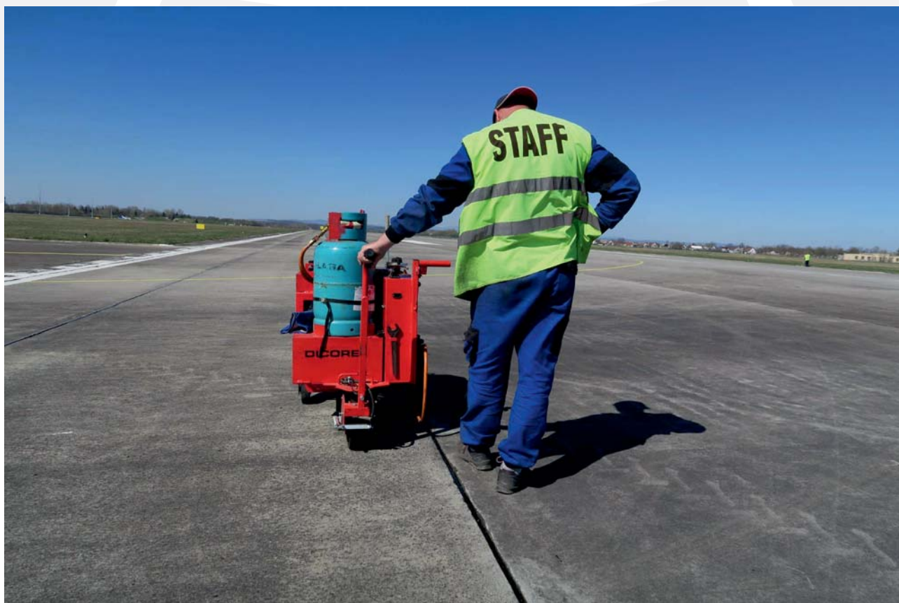
Obr. - Zalévání dilatačních spár asfaltovou hmotou
