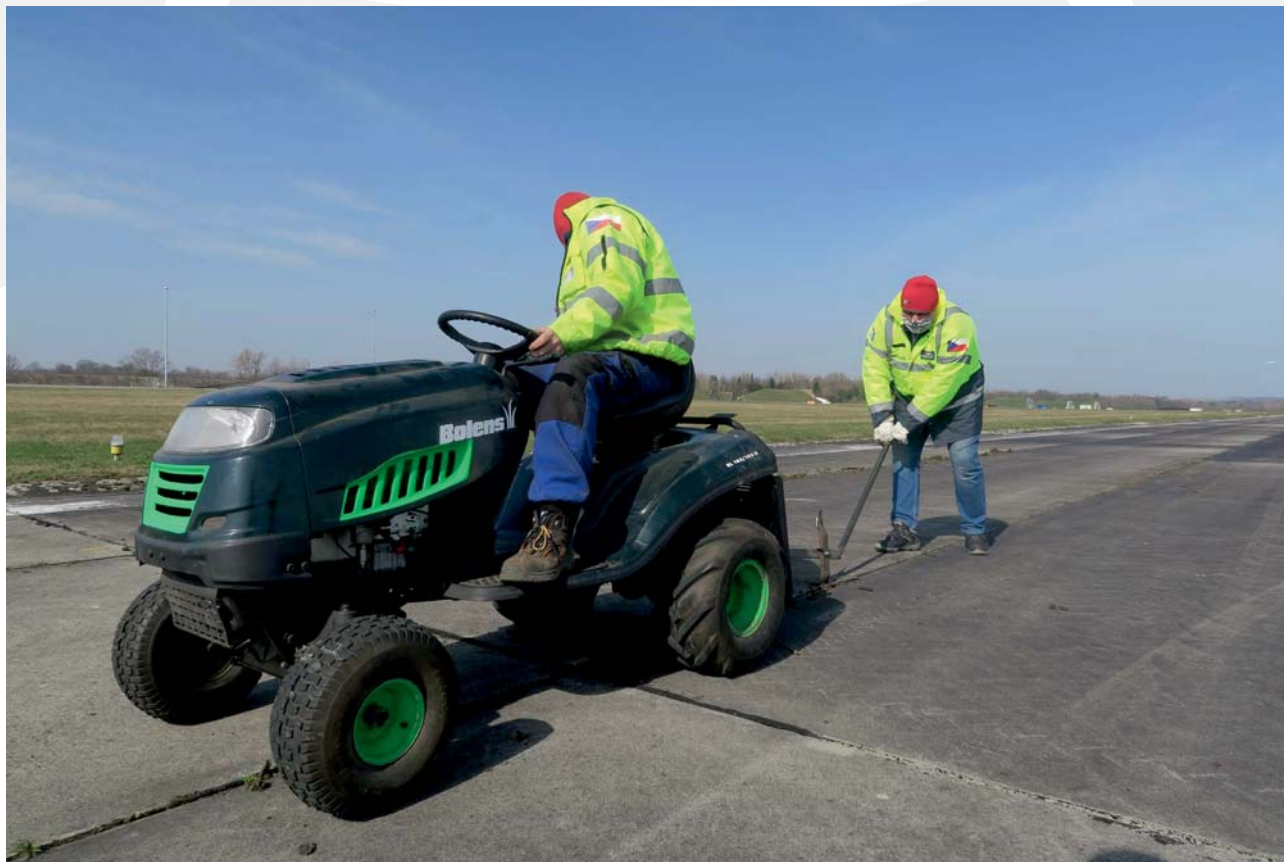
Obr. - Odstraňování starých dilatačních spár a ruční dočištění prostoru mezi panely.
