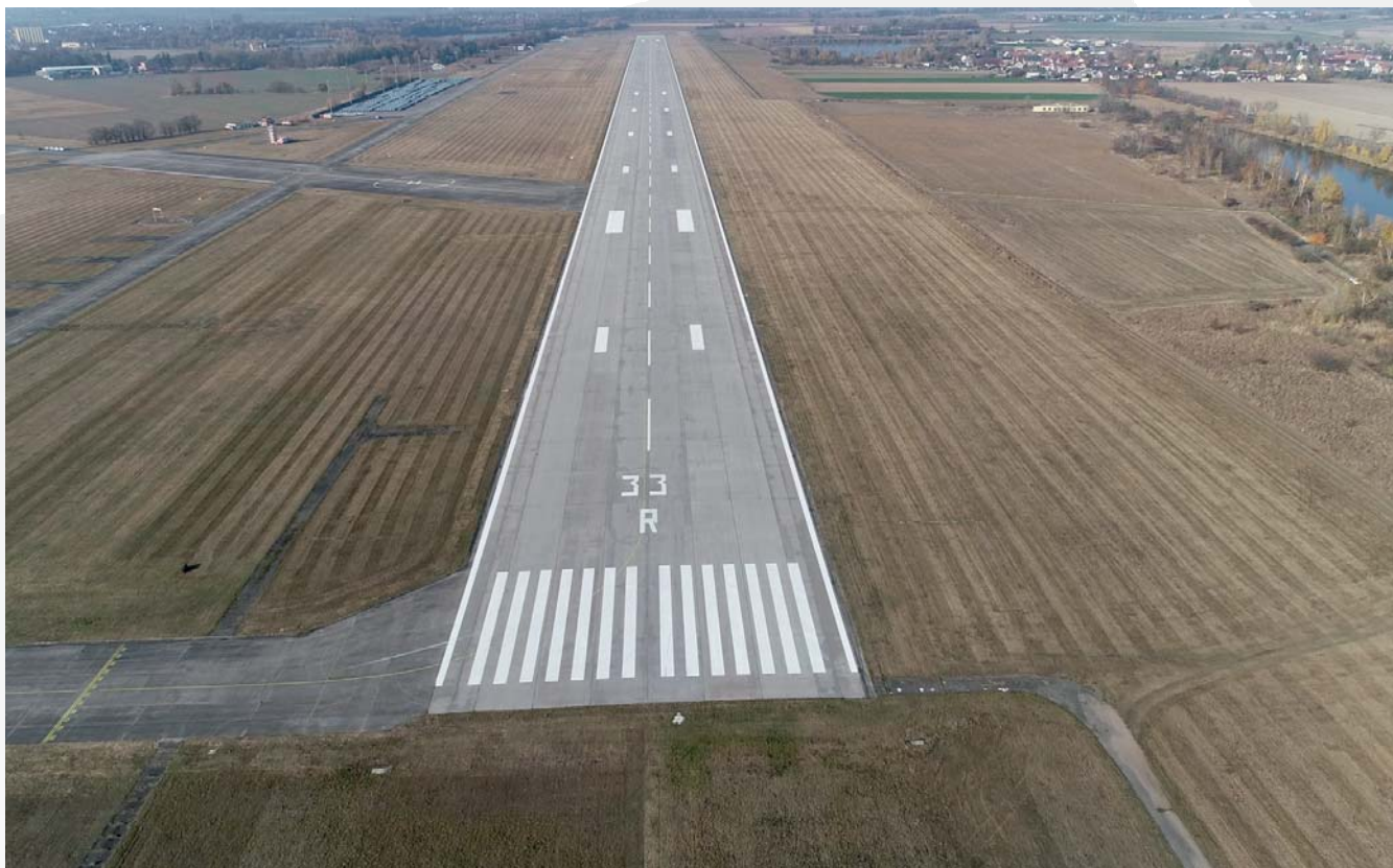
Pohled na RWY 15L/33 R po obnově vodorovného značení
