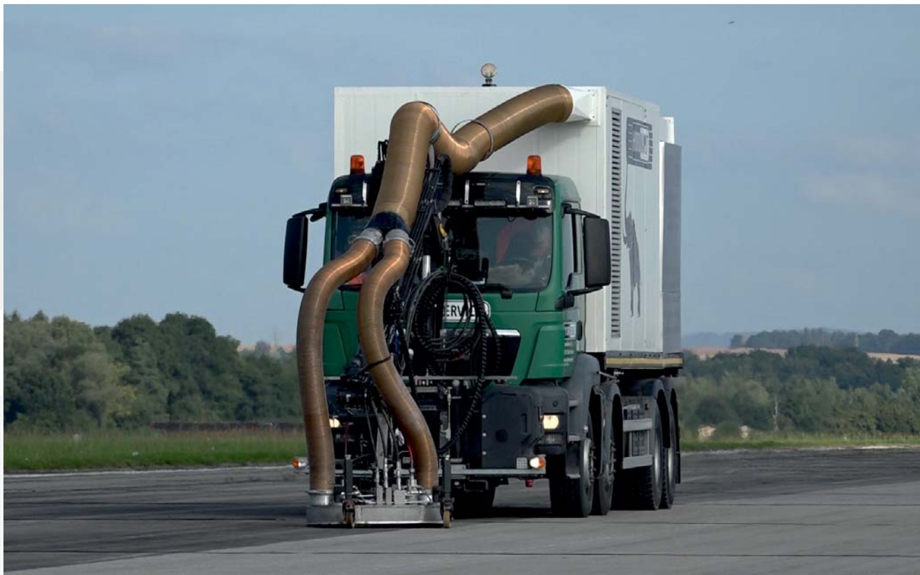
Čištění RWY 15L/33R vysokotlakým vodním paprskem
