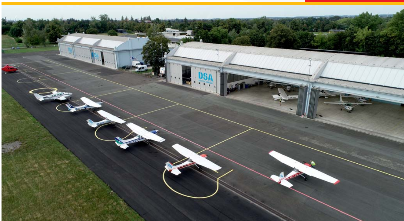
Pohled na letiště po opravě ploch
