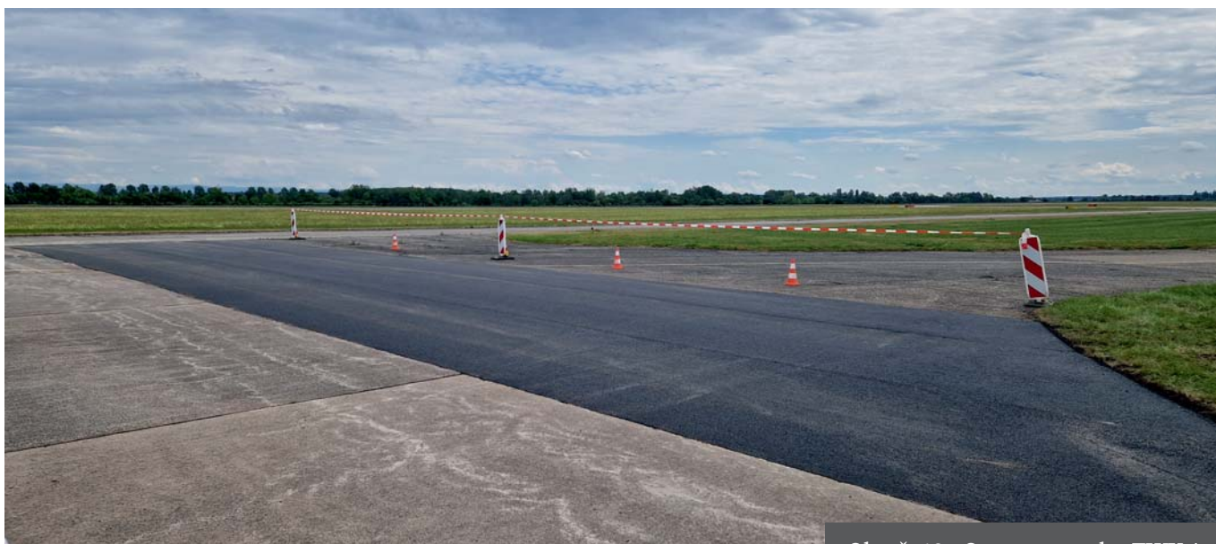
Obr. č. 18 - Oprava povrchu TWY A
