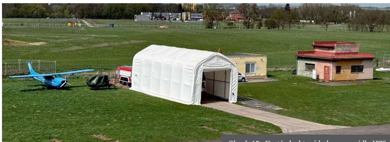
Obr. č. 15 - Krytá plachtová hala pro vozidla HZS
