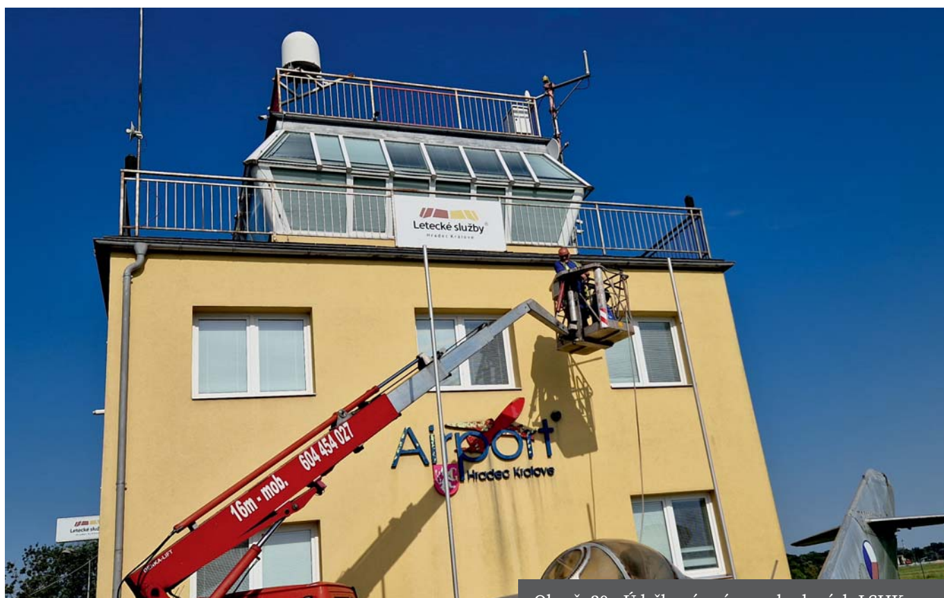
Obr. č. 20 - Údržbové práce na budovách LSHK a.s.
