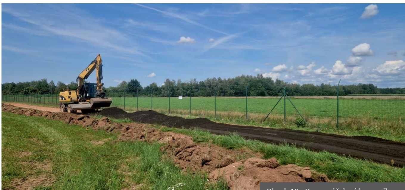
Obr. č. 19 - Oprava účelové komunikace
