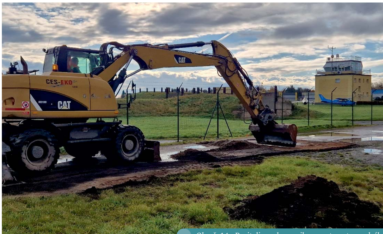
Obr. č. 14 - Revitalizace komunikace na tzv. starou dráhu
