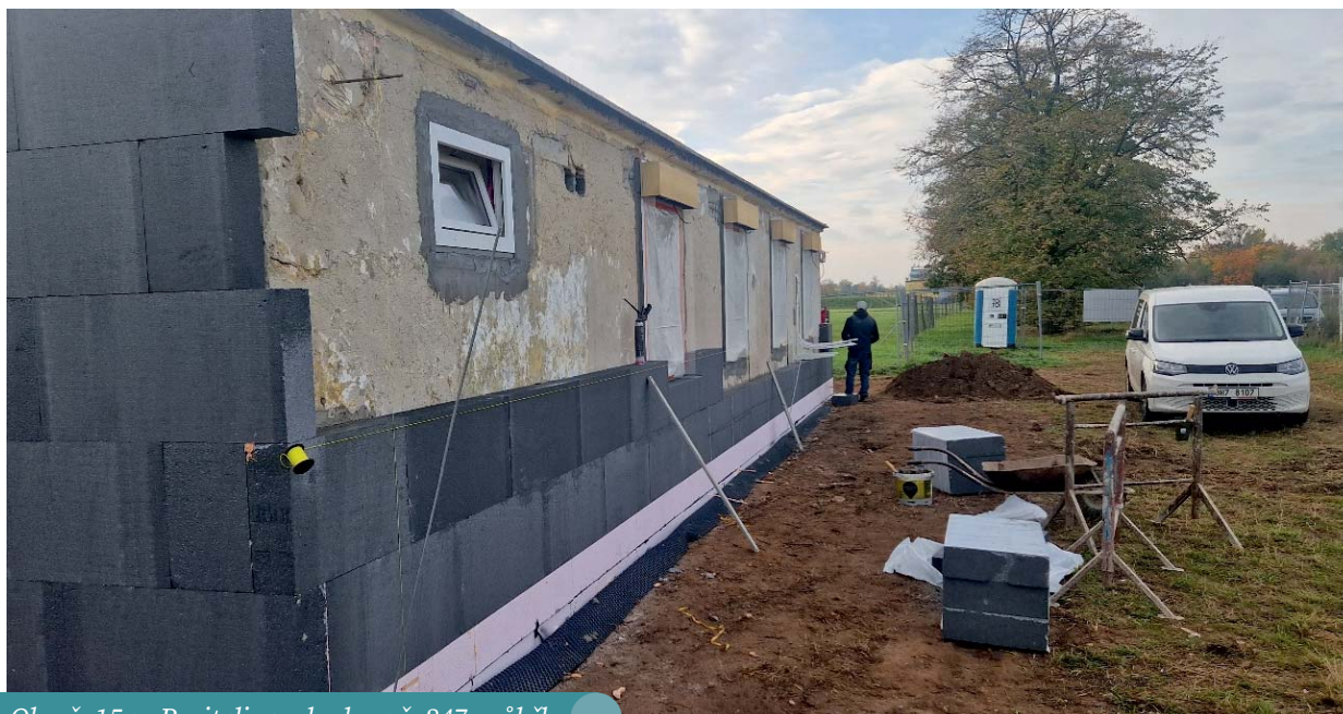
Obr. č. 15a - Revitalizace budovy č. 247 průběh
