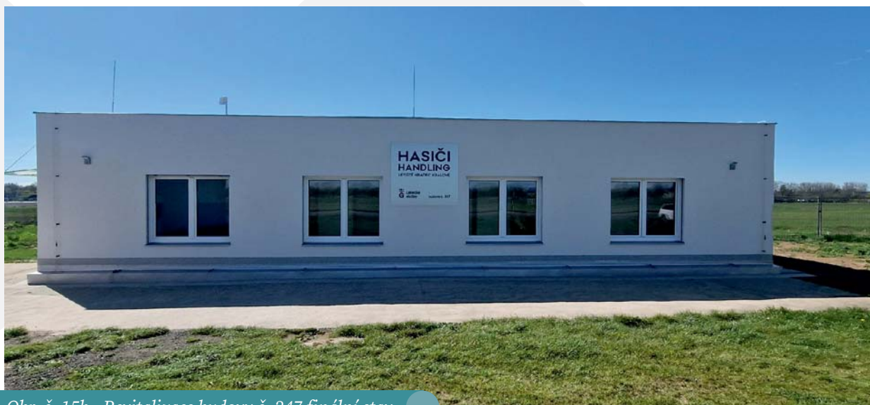
Obr. č. 15b - Revitalizace budovy č. 247 finální stav
