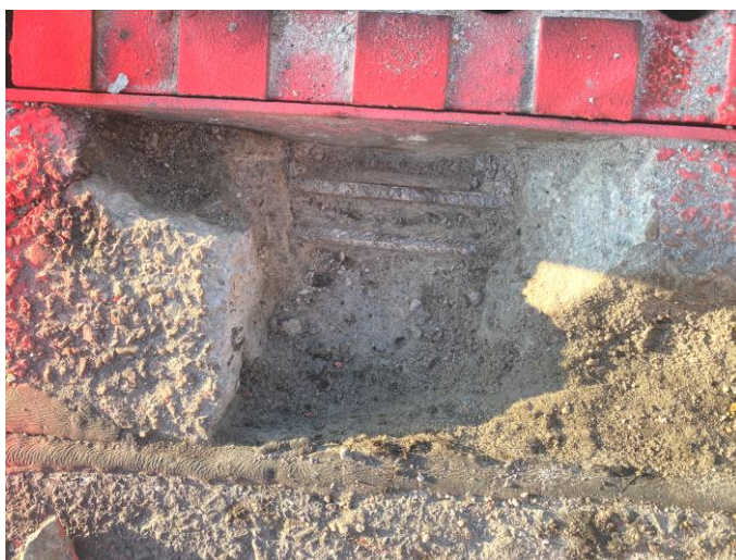
Foto č.2 – Sonda betonového okraje u odvodňovacího žlabu.
